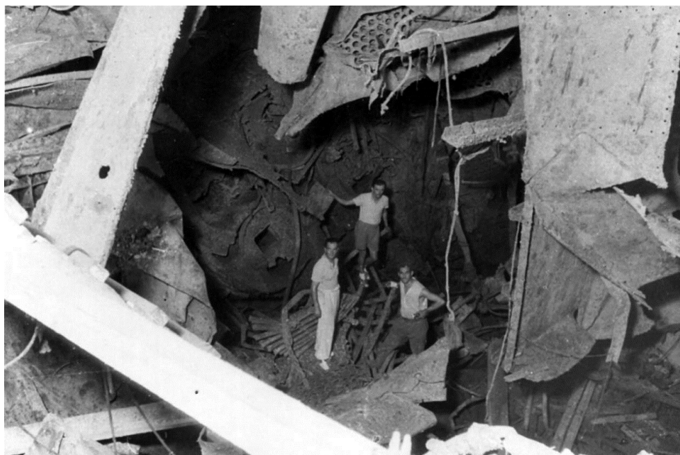
Un'immagine della devastazione della sala macchine causata dall'esplosione (cortesia di Adolfo Orsi jr.)
