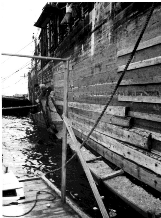
Il tamponamento della falla (cortesia di Adolfo Orsi jr.)
