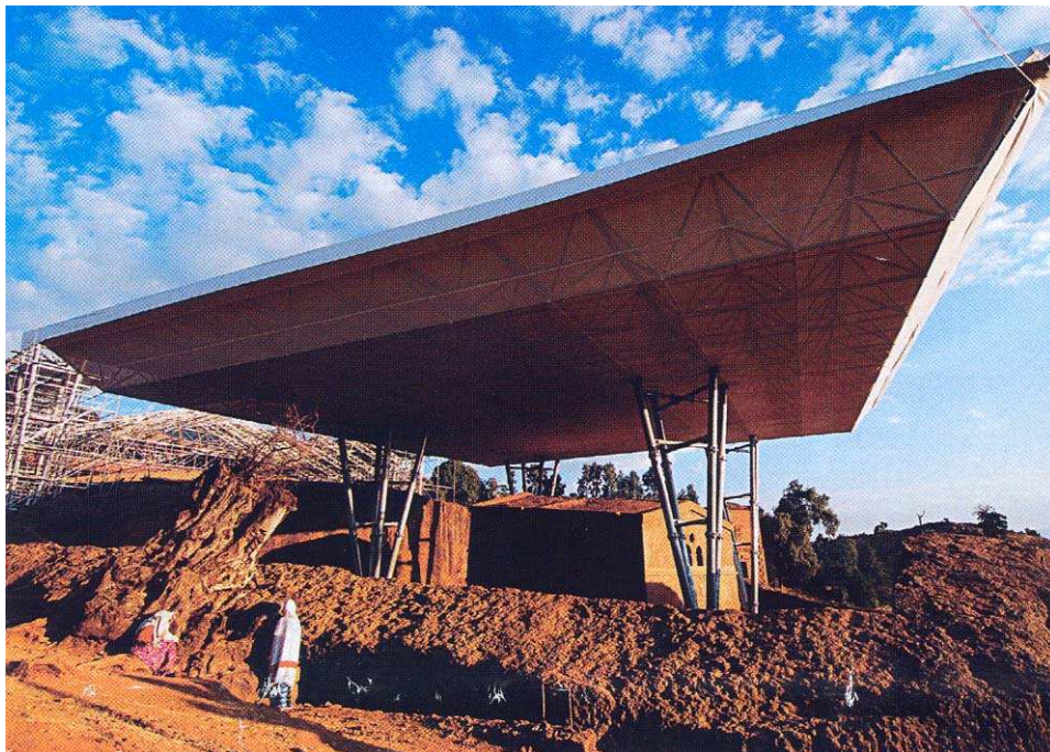
La copertura della chiesa di Biete Mariam (lato nord)
