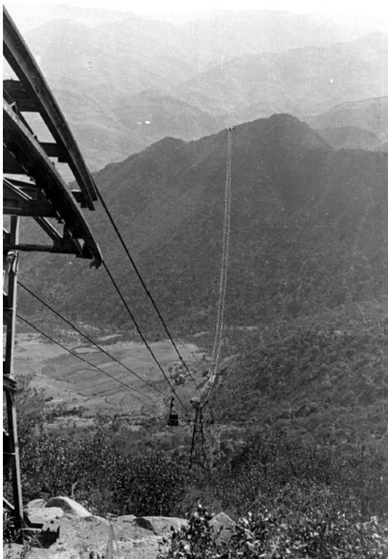
Lungo tutto il percorso vi erano inoltre 464 torri a traliccio (detti “cavalletti”) per il corretto sostegno delle funi, nonché, laddove la teleferica passava sopra la strada asfaltata e la ferrovia, delle 27 tettoie di protezione (5 a protezione della ferrovia e 22 della strada). Il materiale veniva trasportato da 1538 vagoncini, ribaltabili lateralmente, montati in linea, ai quali se ne aggiungevano altri 82 di riserva, distribuiti nelle varie stazioni
