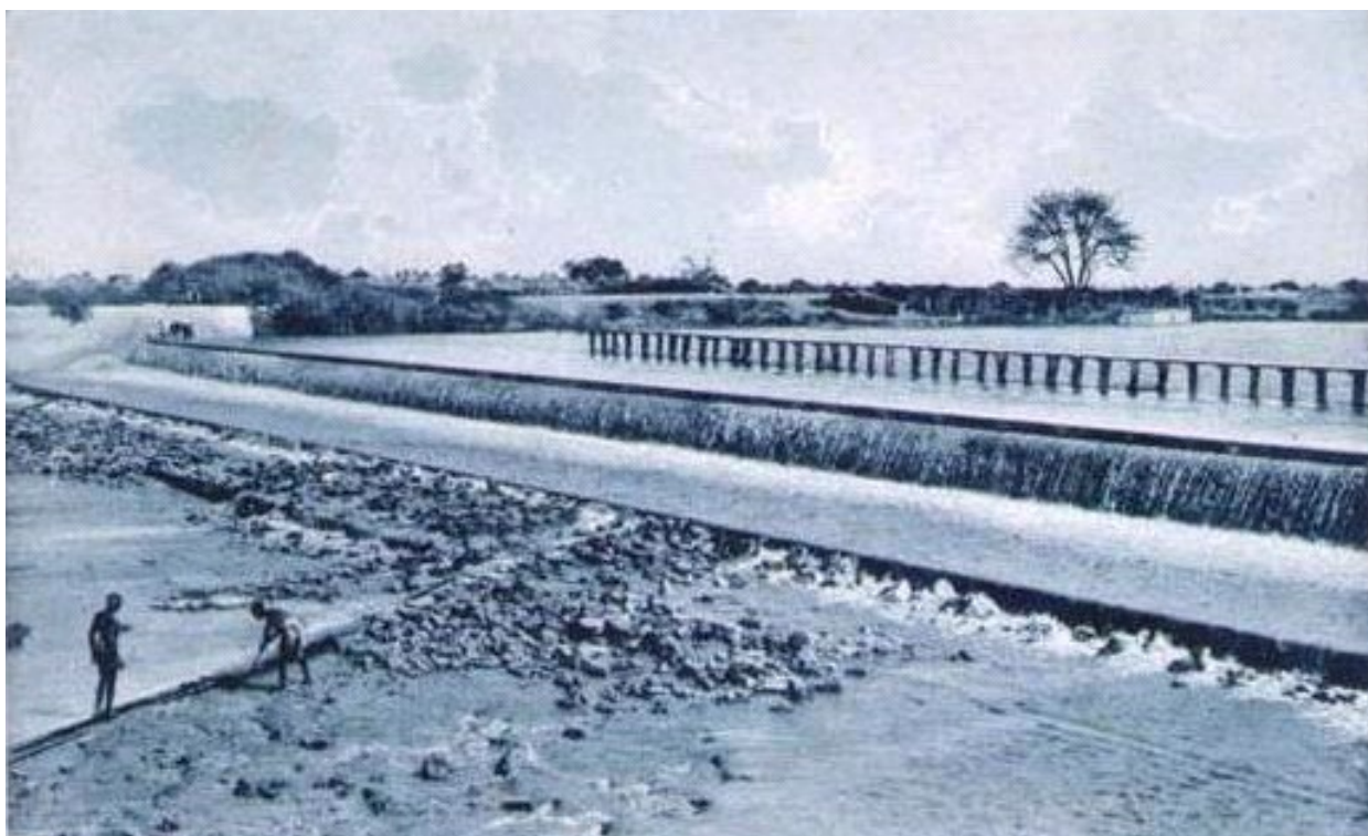
Lo scolmatore di superficie
